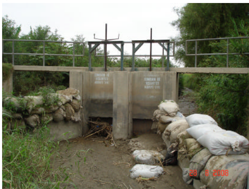
Foto 8.4 Compuerta del comité de regantes de Morrope obstruida y colmatada por lluvias intensas en abril del 2008.
