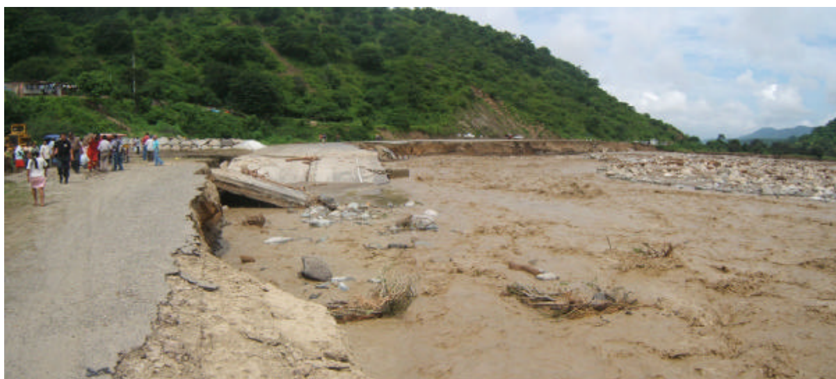
Foto 5.11 Erosión fluvial, en la margen izquierda del río Olmos, Km.14,5 de la carretera Olmos-Jaén.
