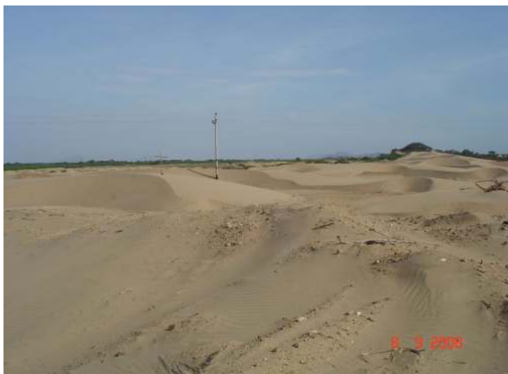
Foto 5.10 Arenamiento en la trocha Nuevo Mocupe-Lagunas (Chiclayo). El avance de las arenas afecta a las obras de infraestructura eléctrica y trocha.
