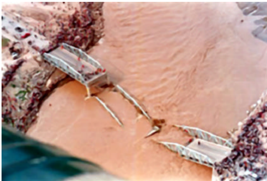
Foto 8.2 Vista aérea del puente Reque, nótese la fractura de sus estructuras a la margen izquierda del río, y a la margen derecha los pilares centrales (SENAMHI, 2004).
