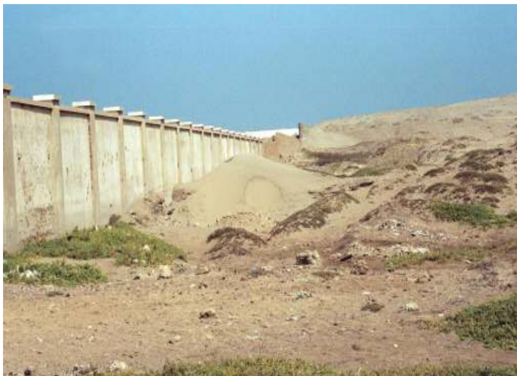
Foto 5.9 Arenamiento en el sector Baldero (distrito de Pimentel, provincia de Chiclayo). Afectó un depósito industrial.
