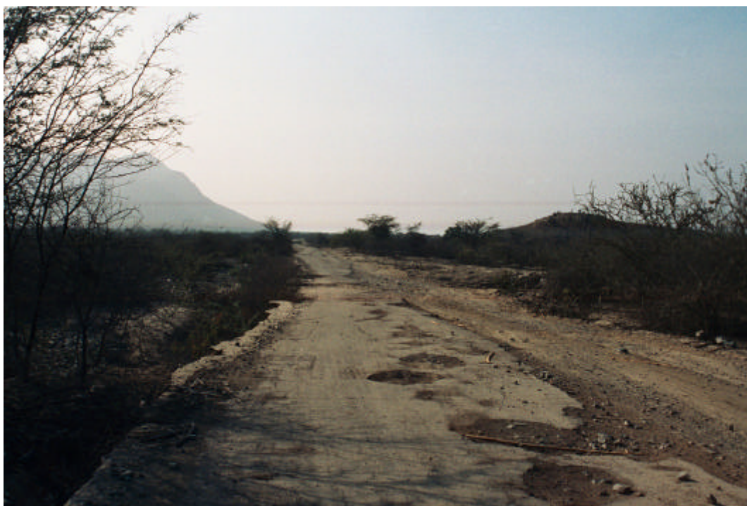
Foto 8.24 Zona crítica N.º 34. Vista de la carretera Ferreñafe-Batán Grande afectada por huayco de la quebrada Vichayal, en el distrito de Mesones Muro, provincia de Ferreñafe (Núñez y Villacorta, 2005).
