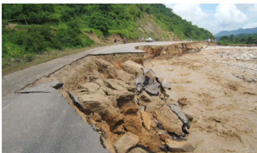
Fotos 8.30 y 8.31 Zona crítica N.º 52. Vista de la erosión fluvial entre Túpac Amaru y La Pílica. Ello afectó, en marzo del 2008, tramos de la carretera Olmos-Jaén.
